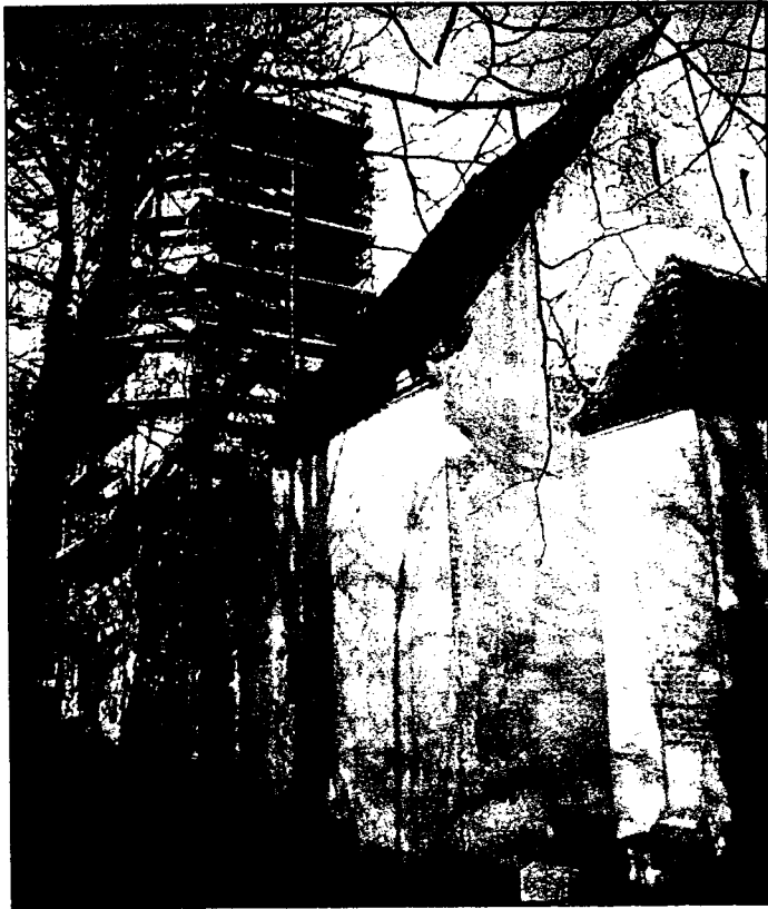
Der Turm bekommt als Übergangslösung ein Notdach. Fo: M.D.
